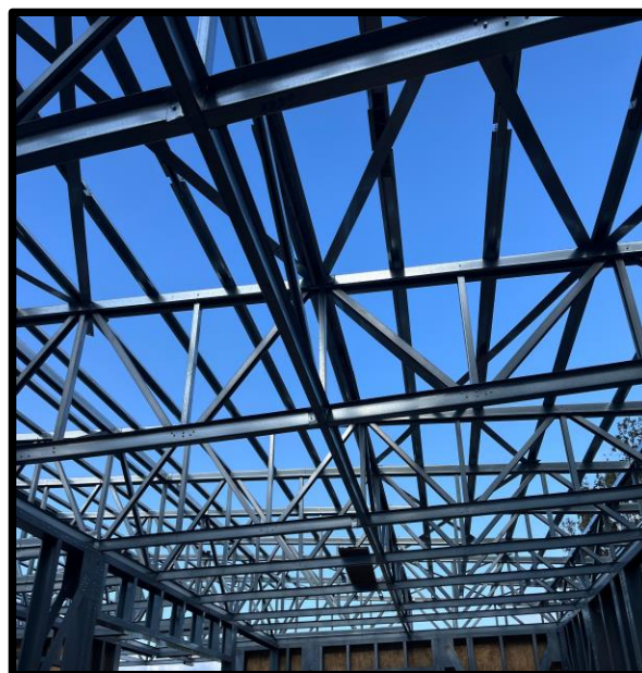
Copertura: unifamiliare 250 mq peso struttura delle capriate 19 kg mq profili acciaio S350GD con trattamento anti corrosione +ZM120 (zincatura allo zinco e magnesio) sp 15/10
